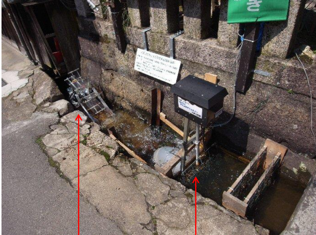
13年12月設置 プロペラ式水車とダストスク リーン 堰取付方式のため簡単に 設置することが可能です
